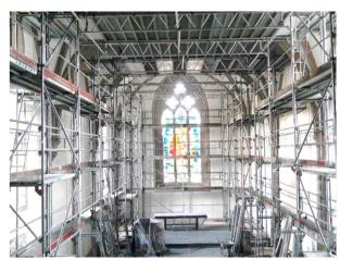
ges Gerüst wurde aufgebaut, begehbar auf der gesamten Fläche unter dem Dach. Nun strahlt die Kirche wieder in frischem Weiß, nur im Vorraum warten noch ein paar Restarbeiten, da dort zunächst das Dach abgedichtet wurde und das Trocknen der Wände abgewartet wird.
